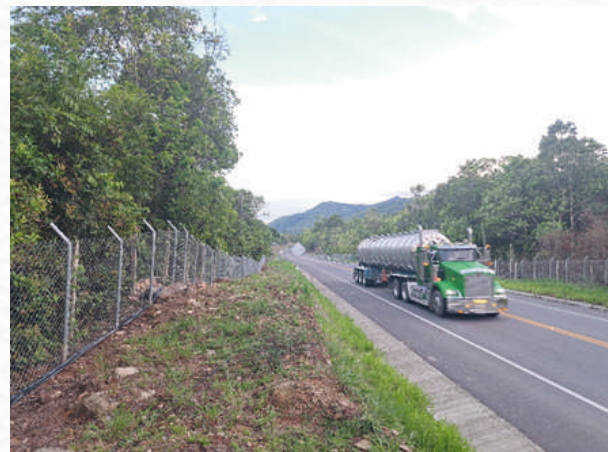
Fotografía 7. Cercado perimetral instalado por Covioriente en la vía Tauramena - Villanueva, para prevenir el atropellamiento de fauna en el departamento de Casanare. Fuente: Fundación Cunaguaro.
